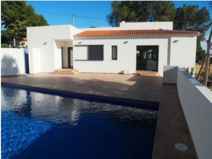
Großzügig geschnittener Poolbereich
